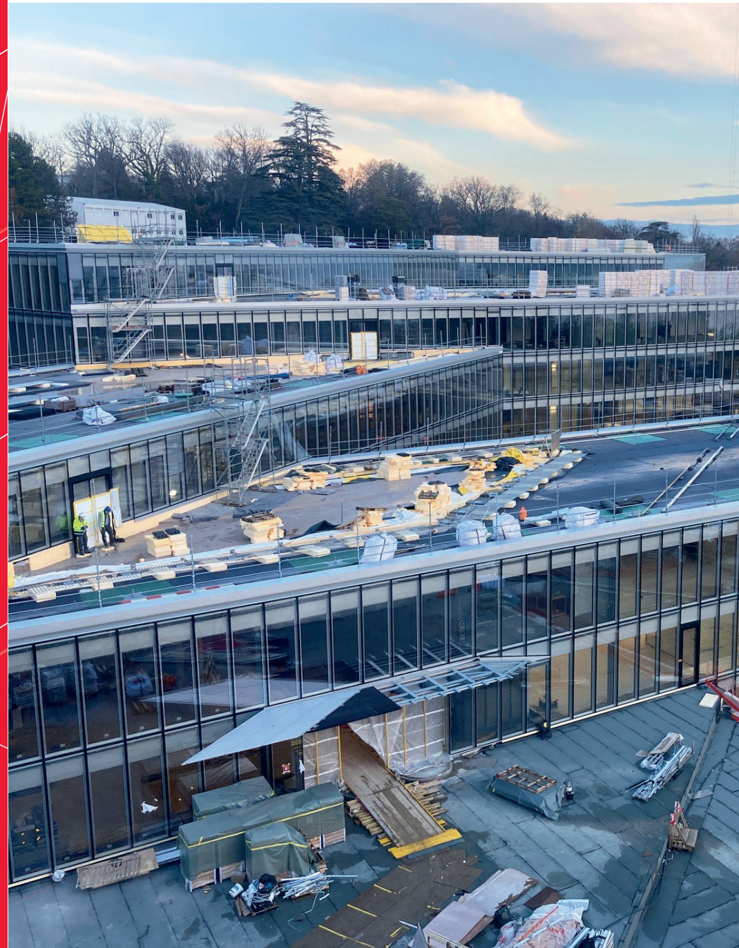
Building H / Bâtiment H (Dec. 2020)
