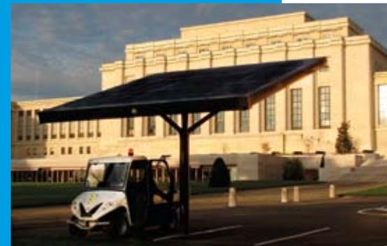
Cellules photovoltaïques et véhicule électrique utilisé par les jardiniers de l'ONUG. (Photo ONU/CSS)
